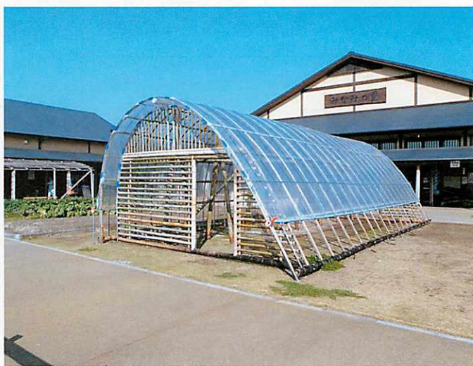
完成した竹ハウス(幅5m,奥行き10m,高さ3m)
